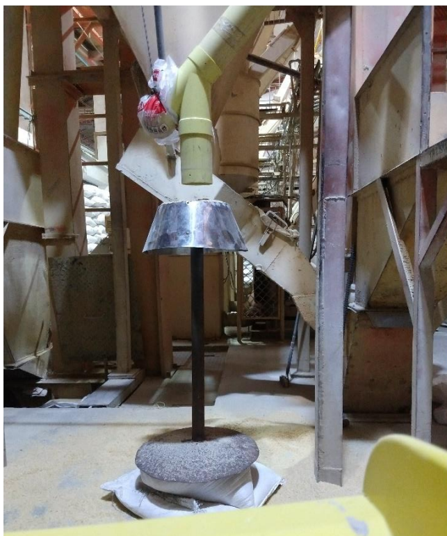
Figura 27. Ensayo de esparcimiento de arroz blanco. Fuente: los autores.
