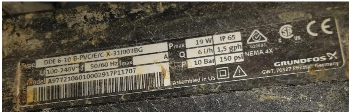
Figura 35. Placa bomba grundfos. Fuente: los autores.
